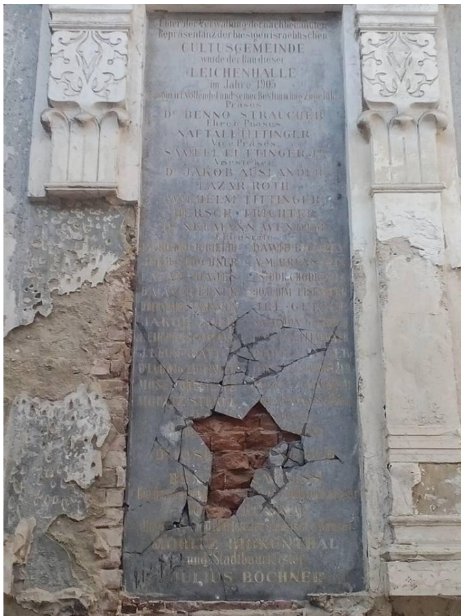
Leichenhalle Innenansicht, mit Beschädigung (Sept.2016)
